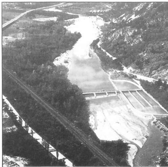
La presa di Pont Ventoux dopo l'intervento.
