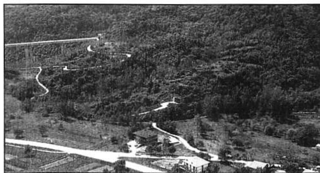
Località Brajda a intervento realizzato.
