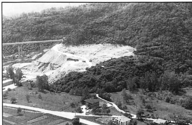
Cantiere località Brajda: situazione attuale.
