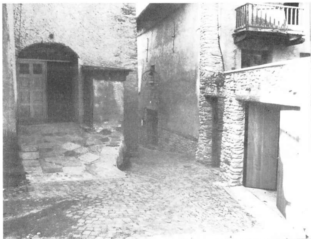
Riselciatura con cubetti in porfido della vecchia pavimentazione.
